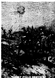
騾馬による電線の引延ばし
